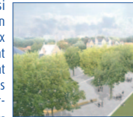
Rénovation complète de la Place Cardinal Mercier
